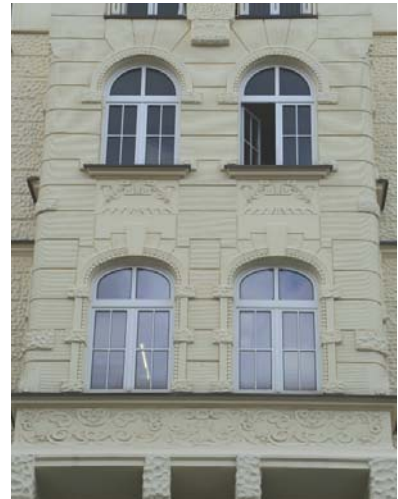
Stuck-Fassade am Kaufhof Bonn (Teilansicht)
