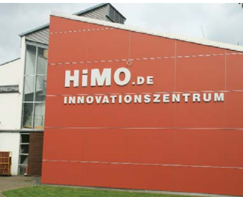
Trespa-Holzfasaden-Verkleidung am Himo Monschau; Sanierung Fachwerkhaus in Monschau; Mietshaus-Fassade (von links)
